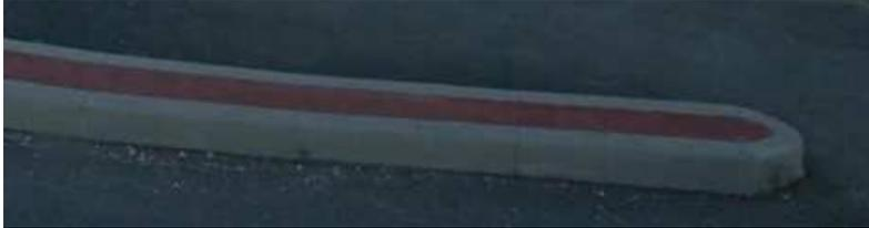
Ne consegue che il marciapiede esistente dovrà essere demolito ed abbassato fino a portarlo alla stessa quota della carreggiata. Va precisato che fino al punto in cui sarà realizzato l'attraversamento pedonale sia il marciapiede che l'elemento spartitraffico saranno realizzati in porfido mentre da quel punto in direzione Thiene saranno utilizzati i normali manufatti in calcestruzzo.
