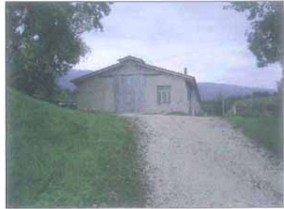
foto n. 02: vista frontale del fabbricato esistente
