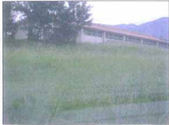
foto n. 01: vista laterale del fabbricato esistente
