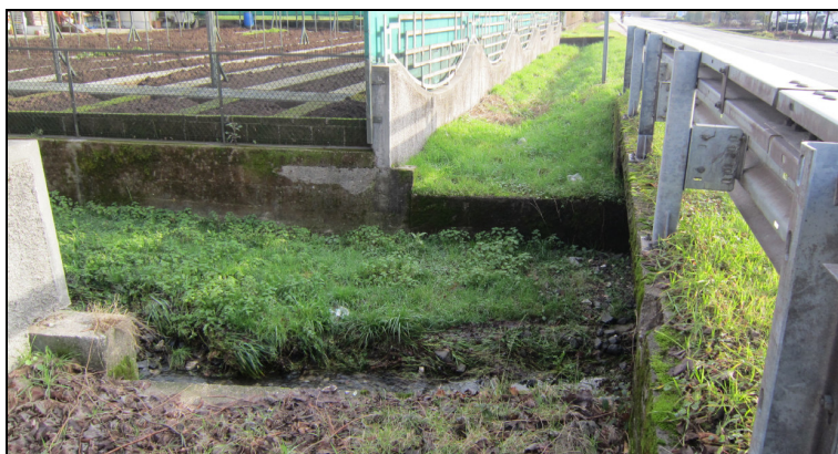
vista del fosso di guardia presente a monte della Strada Provinciale che confluisce nella Valle Grossa.
