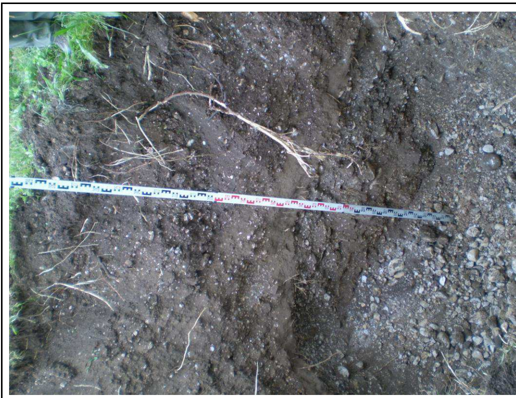
Foto 1: Scavo geognostico T1 (profondità 2,80 m)
