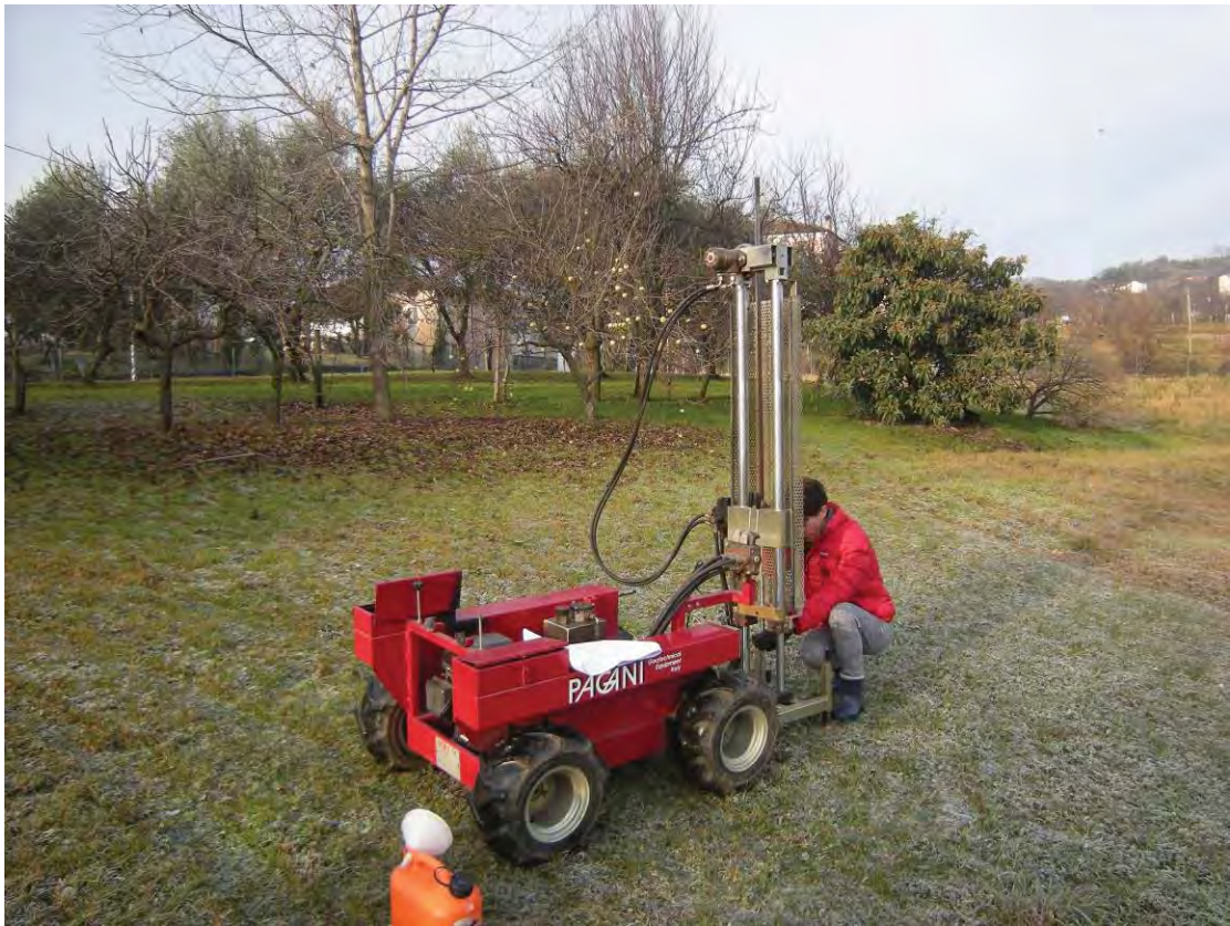
Foto 1: Esecuzione della prova penetrometrica n°1
