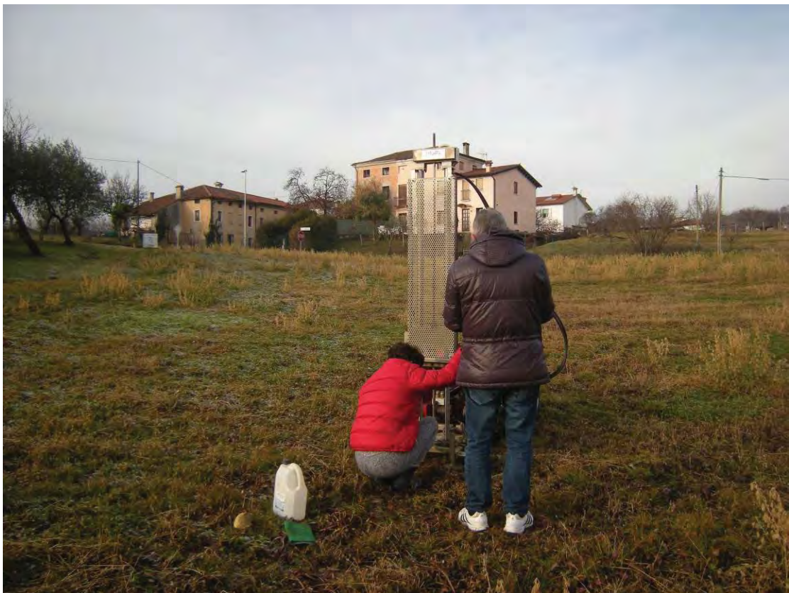
Foto 2: Esecuzione della prova penetrometrica n°2
